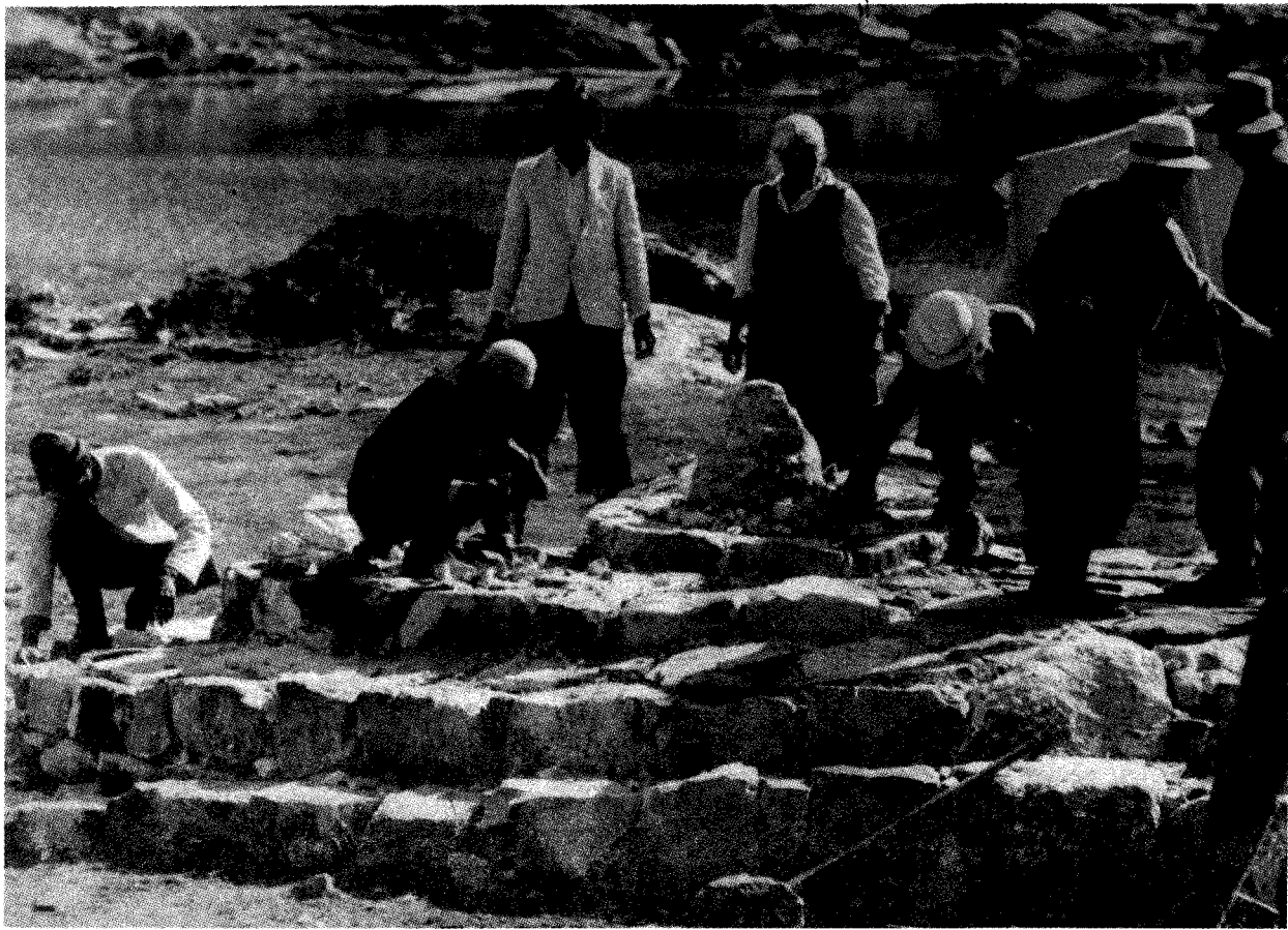
Строеж на спиралата. Учителят с ръка подрежда камъчета към върха на спиралата, така нареченият "охлюв".
